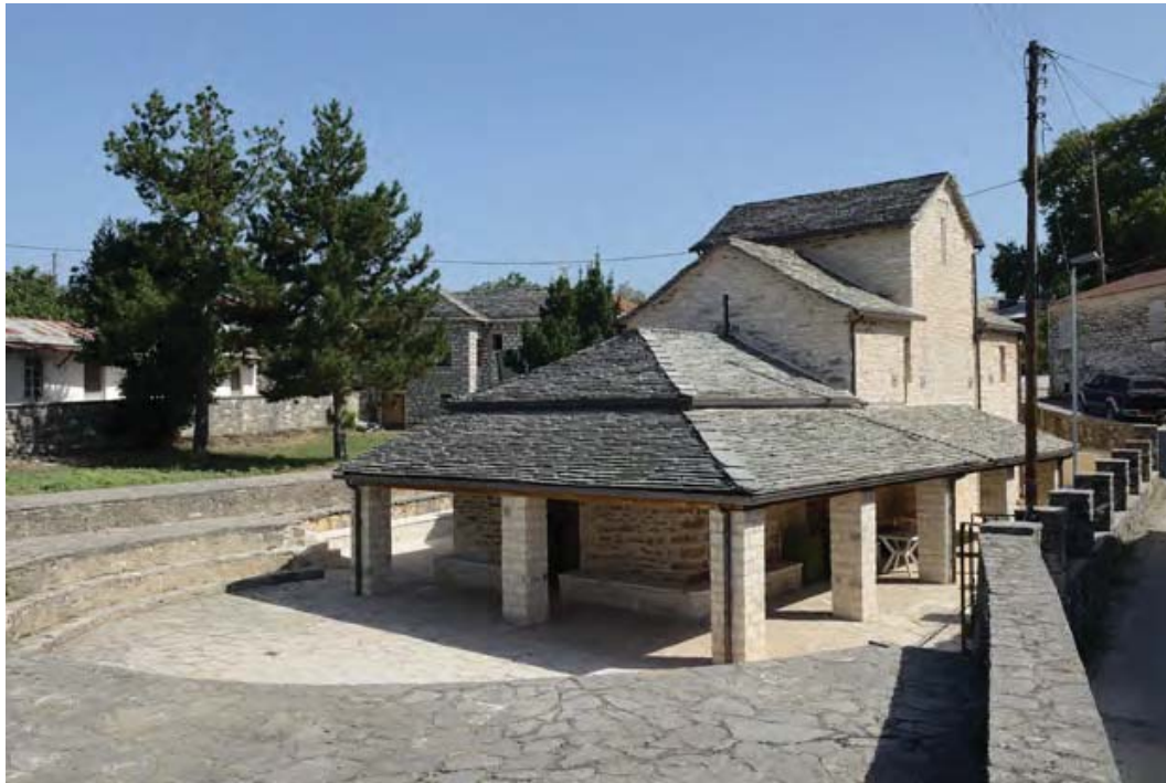
Εικ. 6. Ο Άγιος Δημήτριος Κληματιάς μετά τις εργασίες συντήρησης και αποκατάστασής του. Πηγή: Αρχείο ΕΦΑ Ιωαννίνων.
