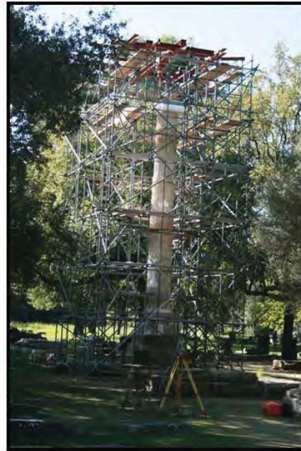
Εικ. 7. Αναστήλωση του κίονα του αναθηματικού μνημείου του Πτολεμαίου Β' και της Αρσινόης Πηγή: Αρχείο Εφ. Α. Ηλείας.
