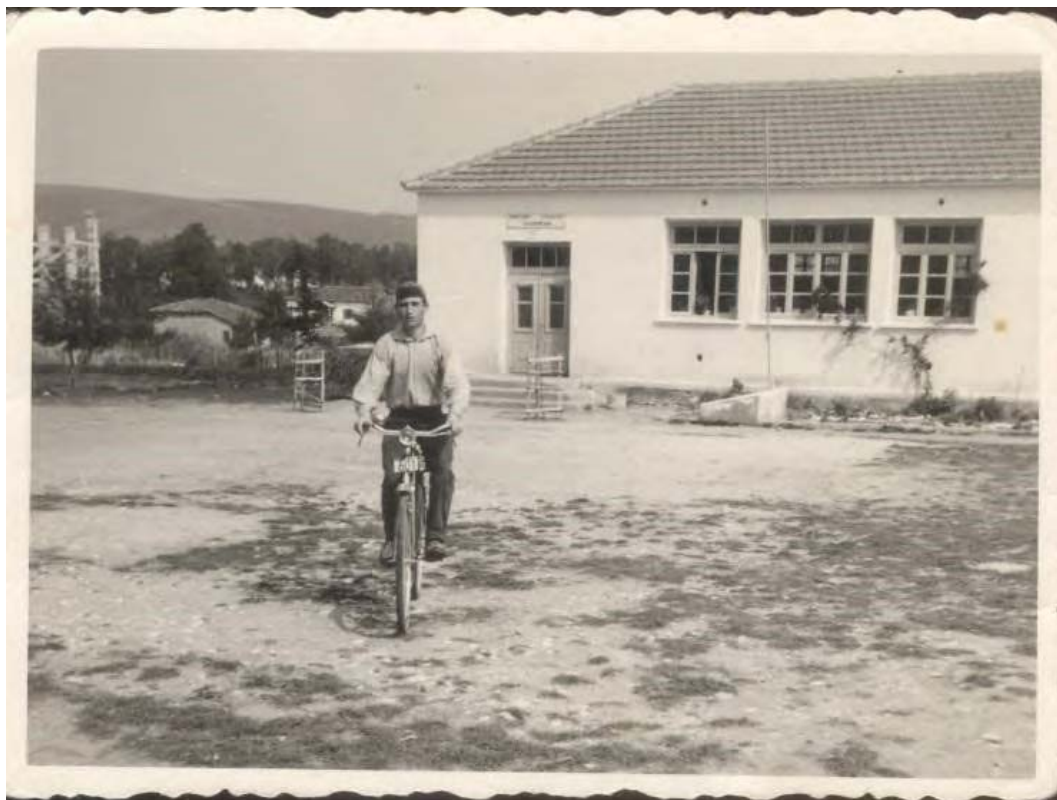
Εικ. 7. Το σχολείο των Παλιαμπέλων σε λειτουργία. Δεκαετία του 1960. Πηγή: Αρχείο Ανασκαφής Παλιαμπέλων ΑΠΘ.
