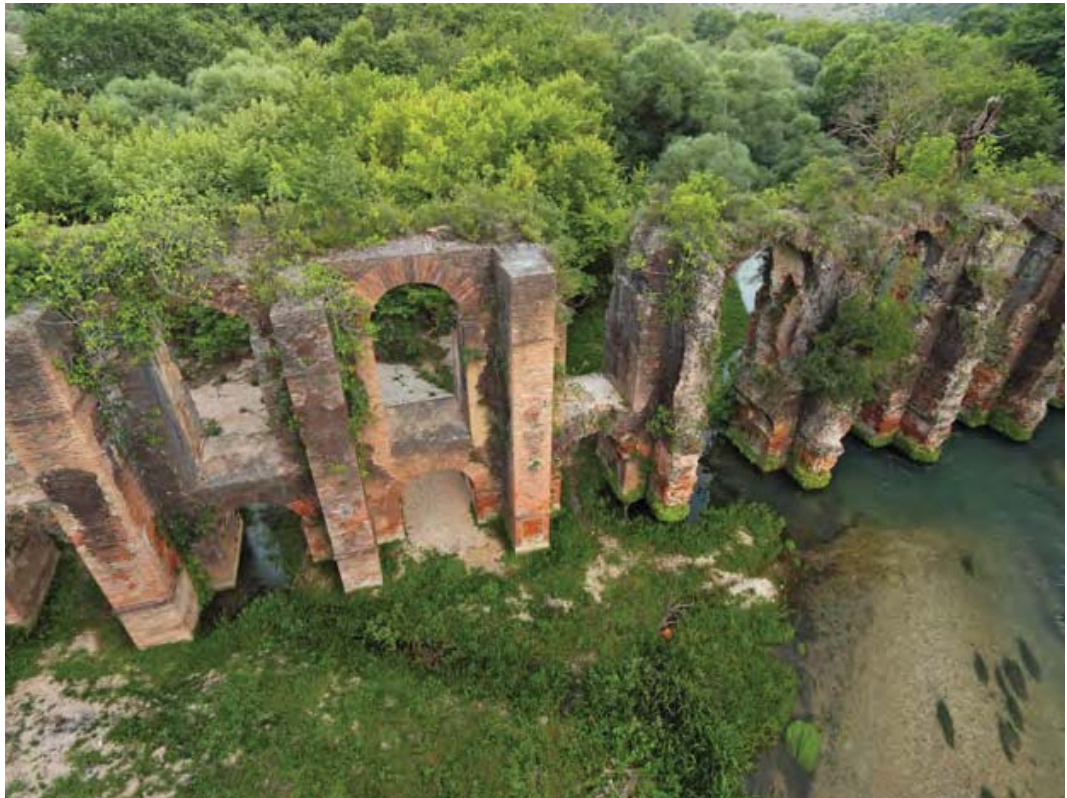
Εικ. 8. Ρωμαϊκό Υδραγωγείο Νικόπολης, Πεσσοστοιχία στη θέση Αγιος Γεώργιος. Πηγή: Αρχείο ΕΦΑ Πρέβεζας.
