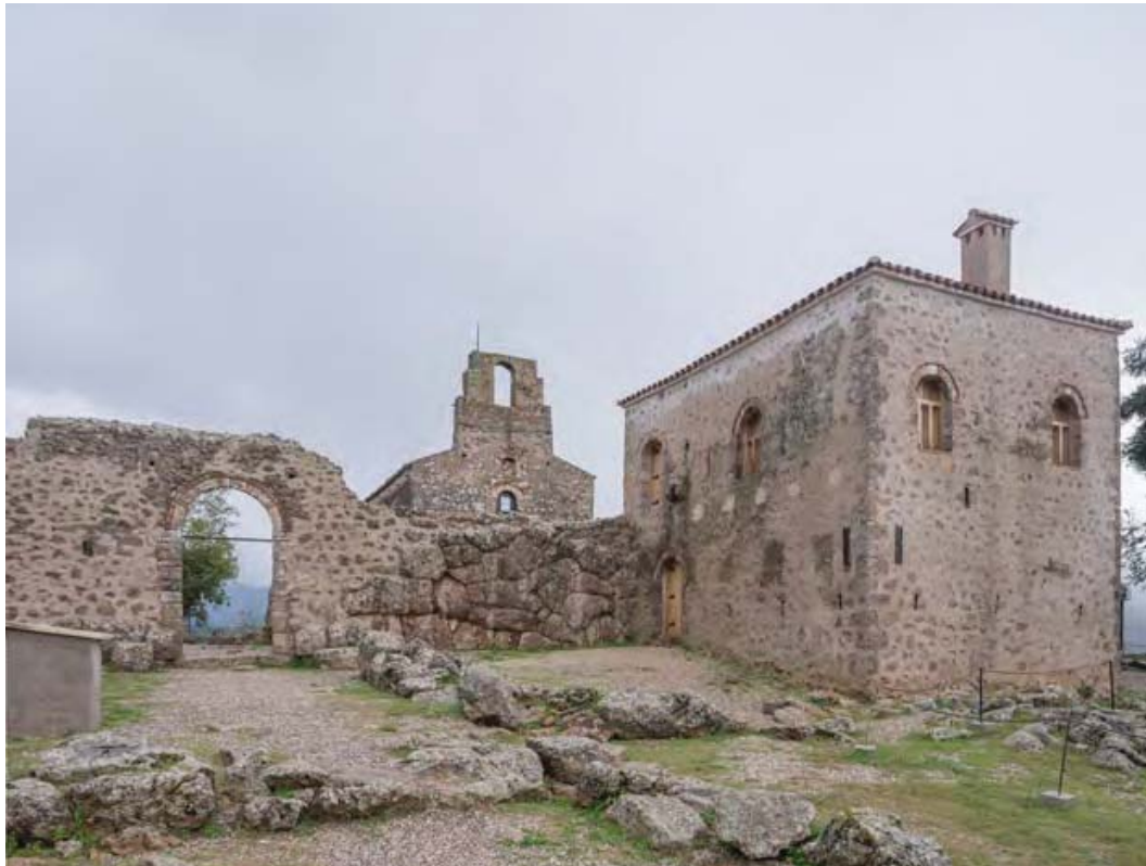
Εικ. 4. Αρχαιολογικός χώρος Νεχρομαντείου. Η κούλια μετά την αποκατάσταση. Πηγή: Αρχείο ΕΦΑ Πρέβεζας.
