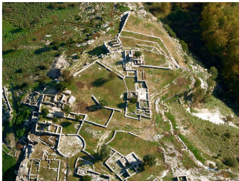
Εικ. 3. Φανοτή-Ντόλιανη. Αεροφωτογραφία της ακρόπολης μετά τις εργασίες ανάδειξης. Πηγή: Αρχείο ΕΦΑ Θεσπρωτίας.
