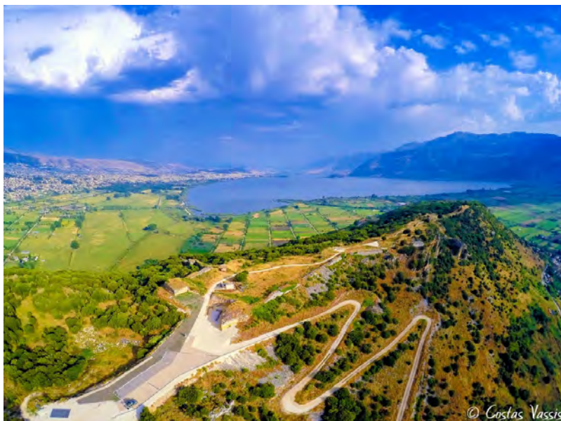
Εικ. 2. Ο αρχαιολογικός χώρος Καστρίτσας μετά τις εργασίες προστασίας-ανάδειξης (γενική λήψη από νότια). Πηγή: Αρχείο ΕΦΑ Ιωαννίνων.
