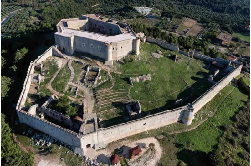
Εικ. 11: Κάστρο Χλεμούτσι μετά τις εργασίες στερέωσης, αποκατάστασης. Πηγή: Αρχείο ΕΦΑ Αχαΐας.
