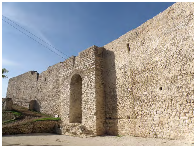
Εικ. 4. Ο Πύργος του Θωμά στο δυτικό σκέλος του Κάστρου των Ιωαννίνων μετά τις εργασίες αποκατάστασής του. Πηγή: Αρχείο ΕΦΑ Ιωαννίνων.
