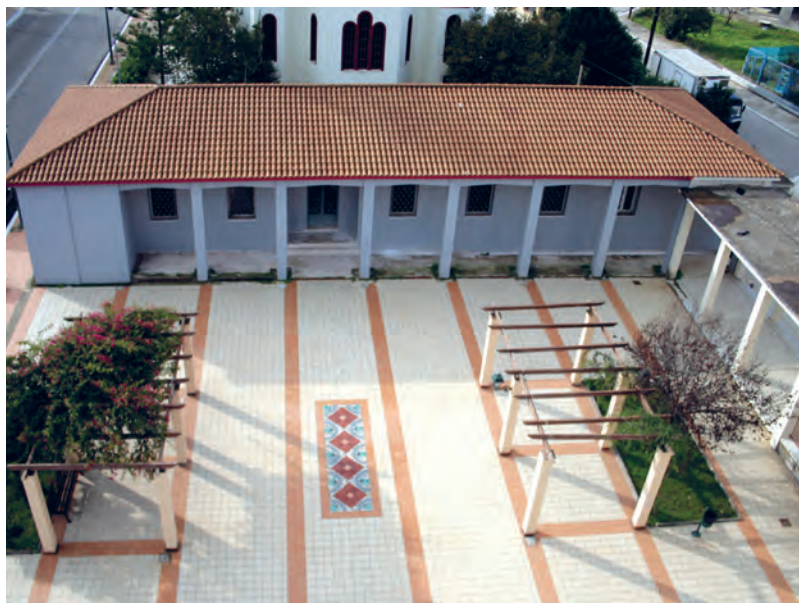
Εικ. 8. Το κτήριο της Αρχαιολογικής Συλλογής Σάμης πριν την έναρξη των εργασιών. Πηγή: Αρχείο ΕΦΑ Αιτωλοακαρνανίας και Λευκάδος.
